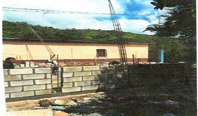
Foto 2: Avance de paredes de block.
