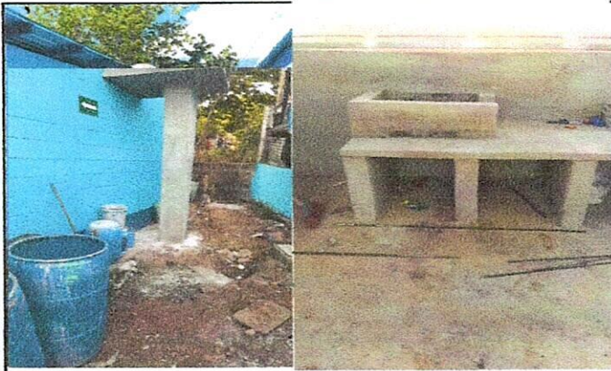
Foto 1: Avance de mejoramiento para base de tinaco y mejoramiento de estufa de leña
