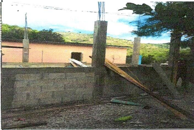
Foto 3: Avance de instalacion de columnas para el techo.
